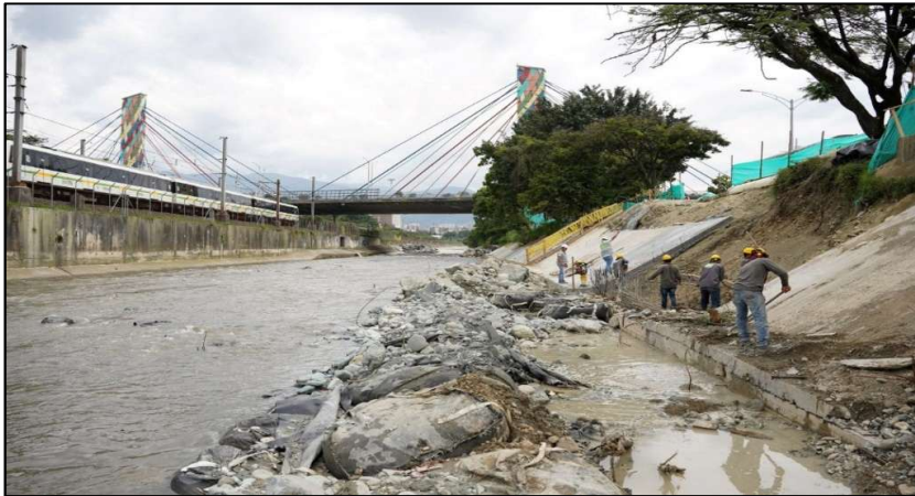
Imagen 28. Desarrollo de obras del programa “Mi Río, Mis Quebradas”, protección de la margen del río Medellín a la altura del Puente de la 4 Sur – Gilberto Echeverri Mejía
