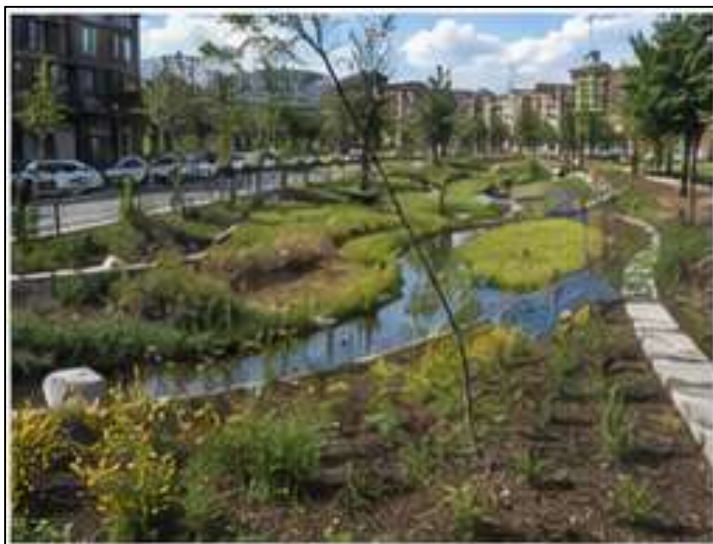
Dresde (Alemania): cuencas de retención, biorretención y zanjas infiltrantes.
