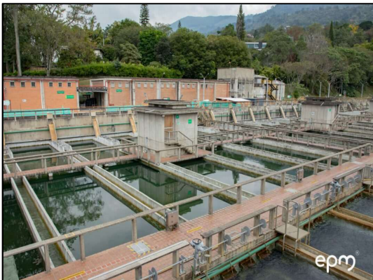
Fuente EPM Planta de Tratamiento Manantiales.
