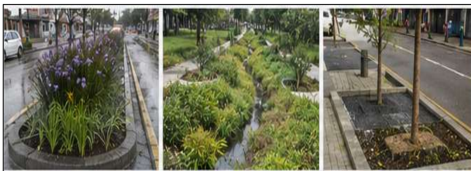
Bogotá D.C.: 1. Avenida Bosa – jardines de lluvia en separadores viales centrales. 2. Bosa y Kennedy – estructura de retención para reducir la presión sobre el alcantarillado pluvial. 3. Avenida 68 – alcorques inundables que captan y retienen el agua lluvia
