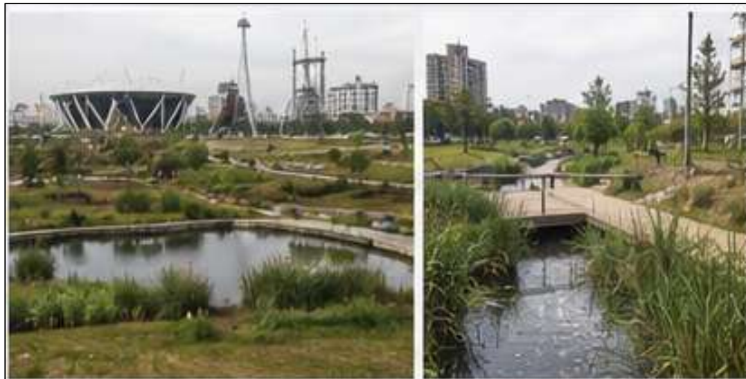
Parque Olímpico Londres (Reino Unido): humedales artificiales, lagunas de retención, pavimentos permeables y zanjas.
