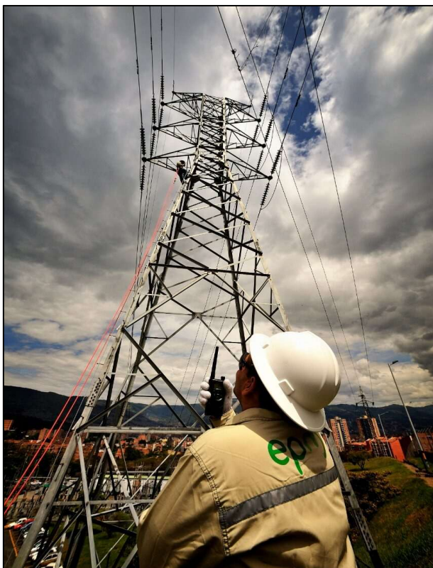
Supervisión torres de energía. Fuente: Banco de fotos EPM
