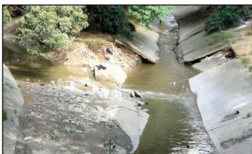
Quebrada La Hueso, sector Estadio. Placas en Mal estado (foto 2026)
