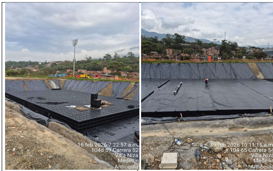
Imagen 26. Proceso constructivo del tanque de tormenta Parque Primavera Norte 2026
