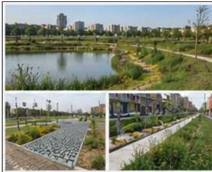
Ho Chi Minh y Hanoi (Vietnam): Estanques de retención, pavimentos permeables, zanjas de infiltración y áreas de biorretención.
